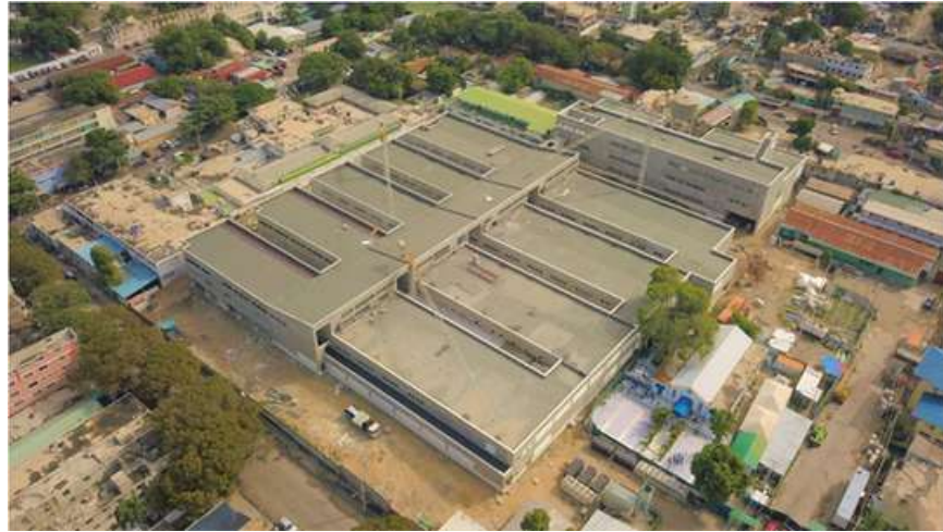
Vue aérienne de la reconstruction de l'Hôpital de l'Université d'Etat d'Haïti
